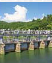
②十六橋水門
