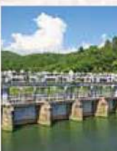
②十六橋水門
